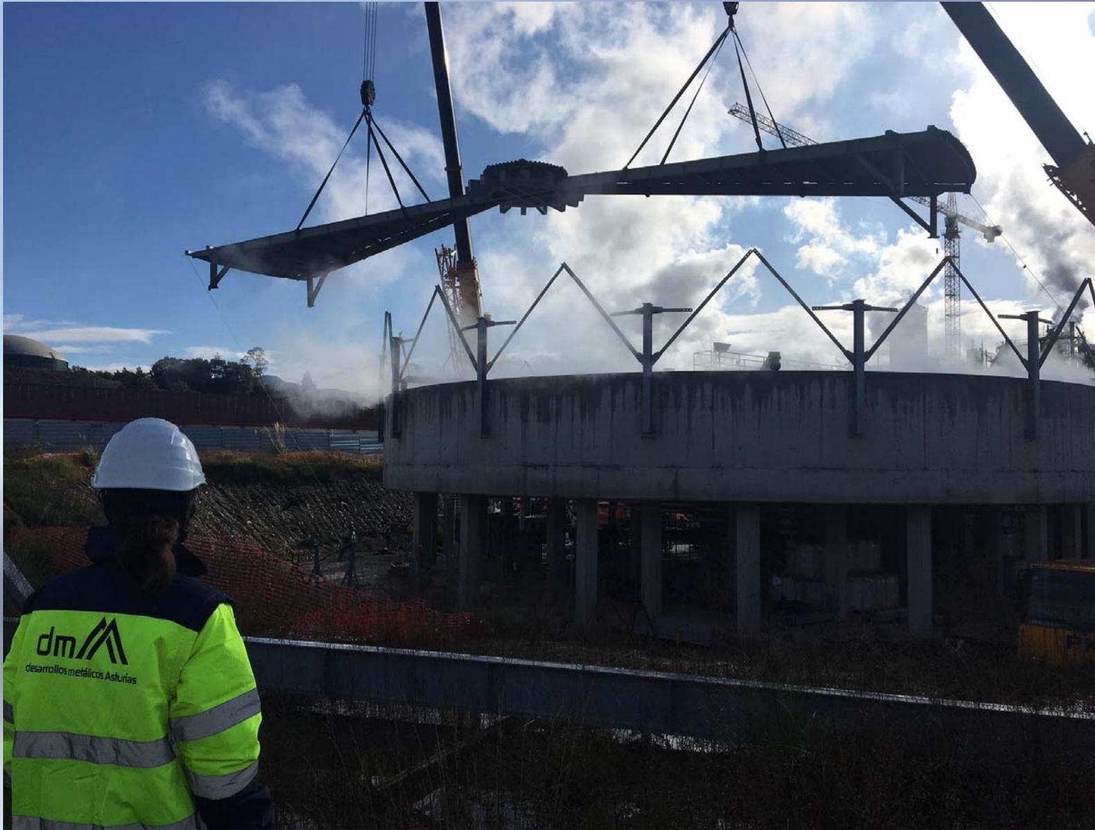
Suministro, fabricación y montaje de estructura sobre decantador en Ence (Navia).
